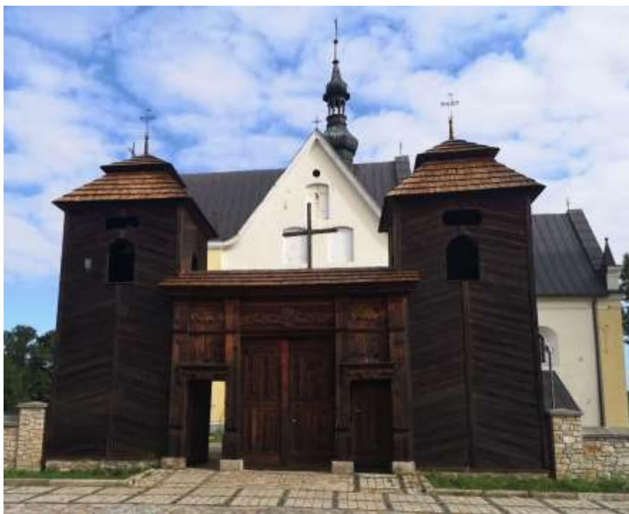
Fot. 3 Brama drewniana z dwiema dzwonicami datowana na 1779 r.
